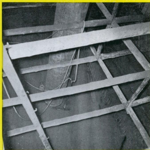
Fondations du marteau-pilon ERIE 16 tonnes. Travaux à 15 m de profondeur, soit à 5 m sous l'eau (la nappe est à 10 m du sol).
